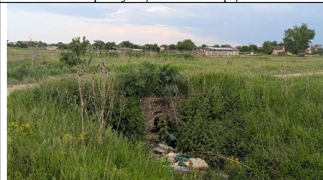
Слика 4: Место укрштања канала и земљаног пута
